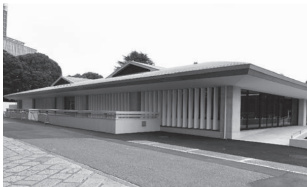
日本武道館中道場棟が完成（令和元年）
