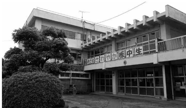
板倉町唯一の中学校である本校の校舎
